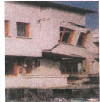
خیز تیر در اثر نیروهای وارده، تخریب دیوار محیطی - زلزله ترکیه ۱۹۹۹
