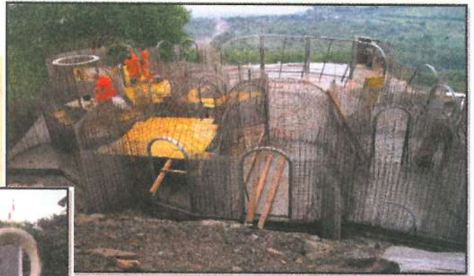
شکل ۱۵، نحوه ساخت خانه حلزونی
