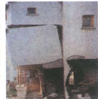
خیز تیر در اثر نیروهای وارده، تخریب دیوار محیطی - زلزله ترکیه ۱۹۹۹
