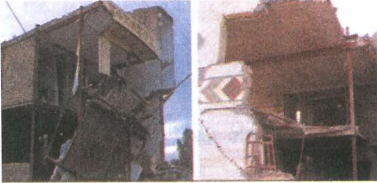
خیز تیر در اثر نیروهای وارده، تخریب دیوار محیطی - زلزله ترکیه ۱۹۹۹
